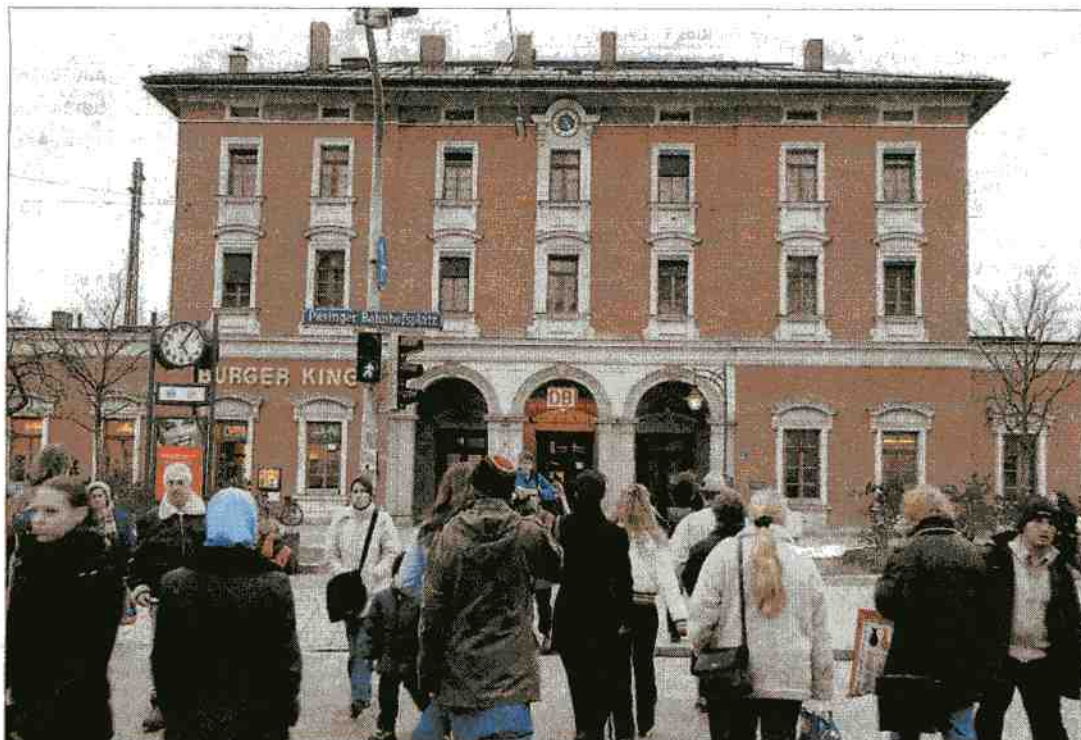
Bayerns viertgrößter Bahnhof wird umgebaut: Zu jedem Bahnsteig sollen künftig ein Aufzug und zwei Rolltreppen führen. Foto: Rumpf
